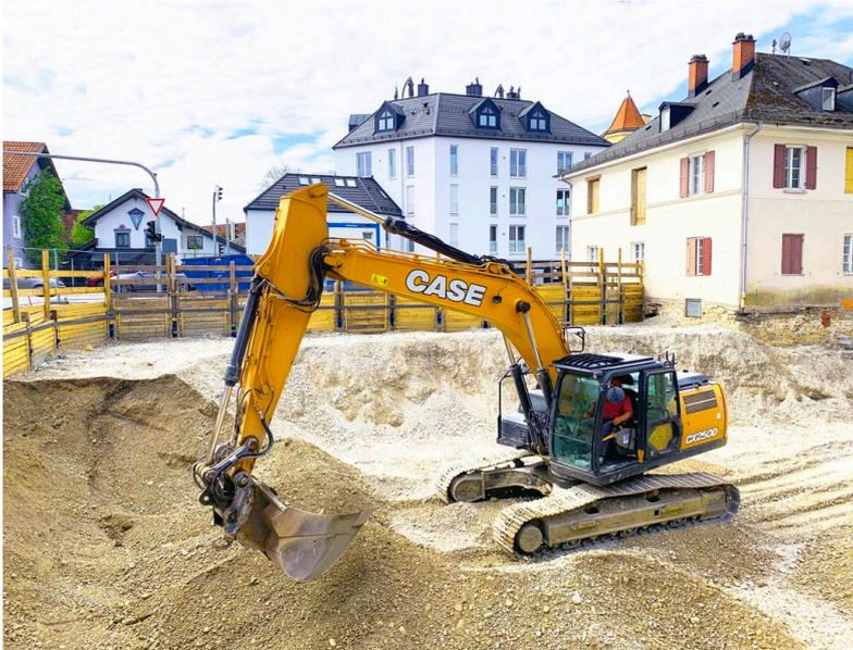
Der „Verbau“ ist im Hintergrund gut zu erkennen. Er stabilisiert den Baugrund.
