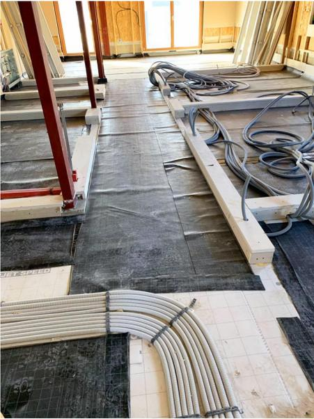
Bei den Böden geht es Schicht auf Schicht. In weiß ist die Trittschalldämmung zu erkennen, die schwarze Folie bildet die Dampfsperre.
