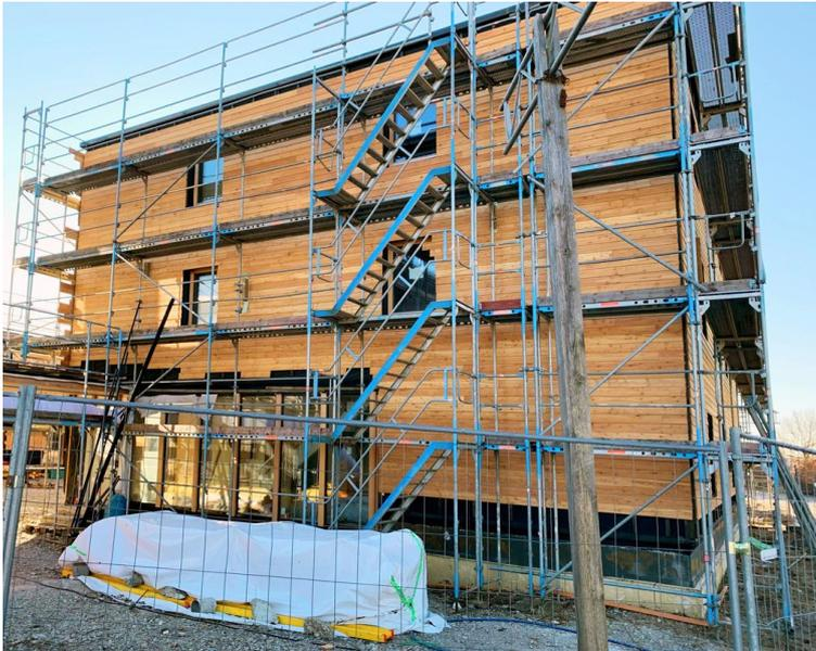
... und weiter gehts mit der Fassade aus Lärchenholz. An den Hausecken wird nun auch zugeschnitten - nur der Kantenschutz fehlt noch.
