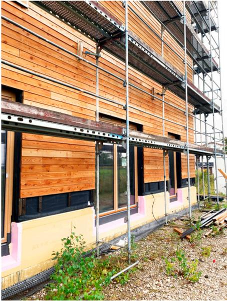
In gelb und rosa ist hier die Sockeldämmung zu sehen. Die Noppenfolie, weiter unten, wird später nach oben geschlagen und befestigt. Damit werden Fundament und Fassade gegen Feuchte geschützt.
