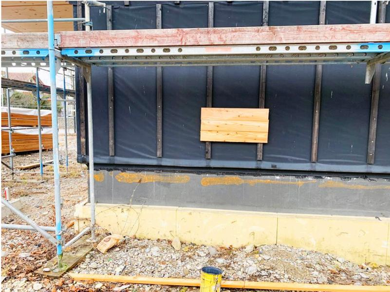
Das Fassadenholz für die Holzstülpeschalung aus Lärche ist geliefert. Für den ersten Eindruck wird auch ein kleines Probestück angebracht.
