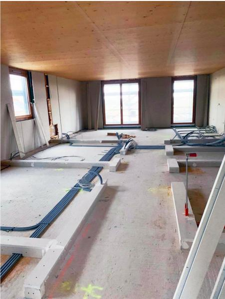
Was zunächst chaotisch aussieht wird nun fein säuberlich verlegt. So können dann auch die Stromkabel in die Leerrohre gebracht werden.
