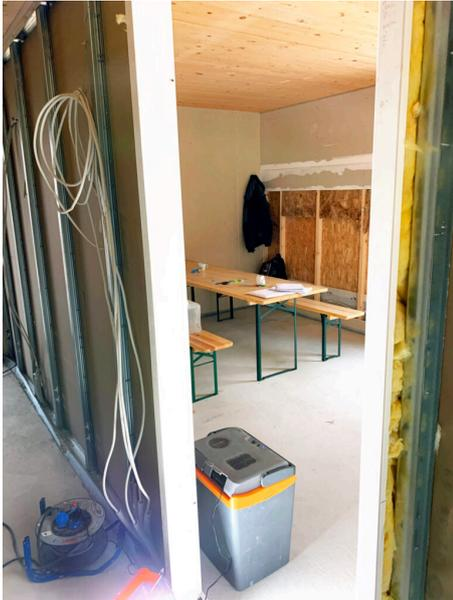
Der Estrich ist eingebracht. Das Aluständerwerk ist bisher einseitig beplankt – so können später noch Dämmung und Leitungen angebracht werden.
