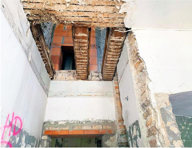
Für neue Leitungen: Der Durchbruch erlaubt Einblicke in den 200 Jahre alten Boden-Decken-Aufbau.
